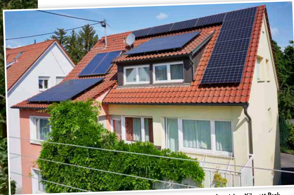
Die PV-Anlage von Günter Schweier hat eine Leistung von fast sieben Kilowatt Peak.
