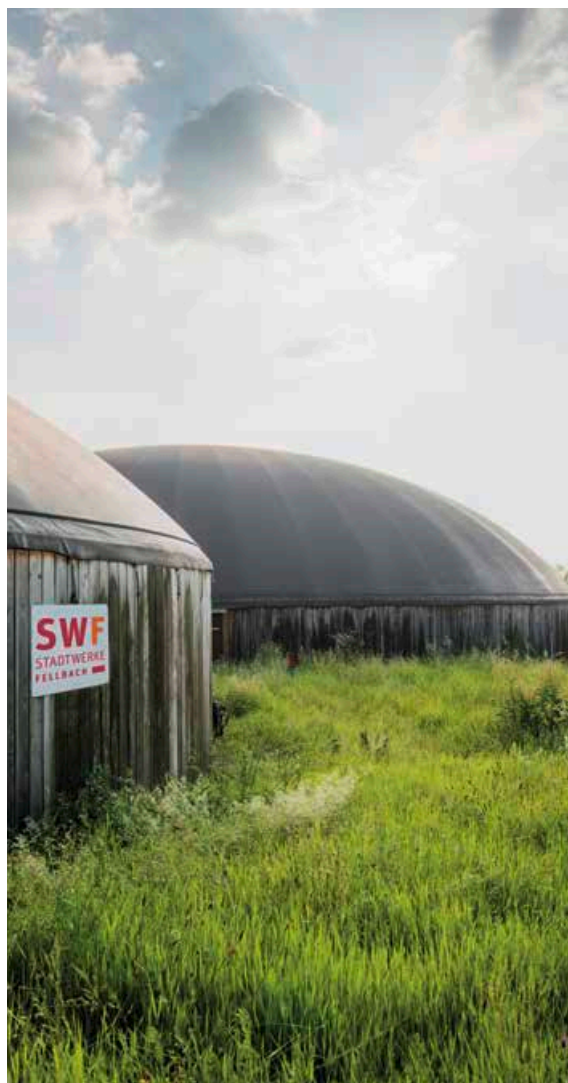
In ihrer Biogasanlage erzeugt die SWF Biogas aus nachwachsenden Rohstoffe wie Maissilage und Gras.
