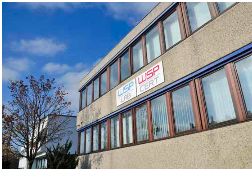
WSPLab prüft in Bad Cannstatt die Leistung von Heiz- und Kühlgeräten.
