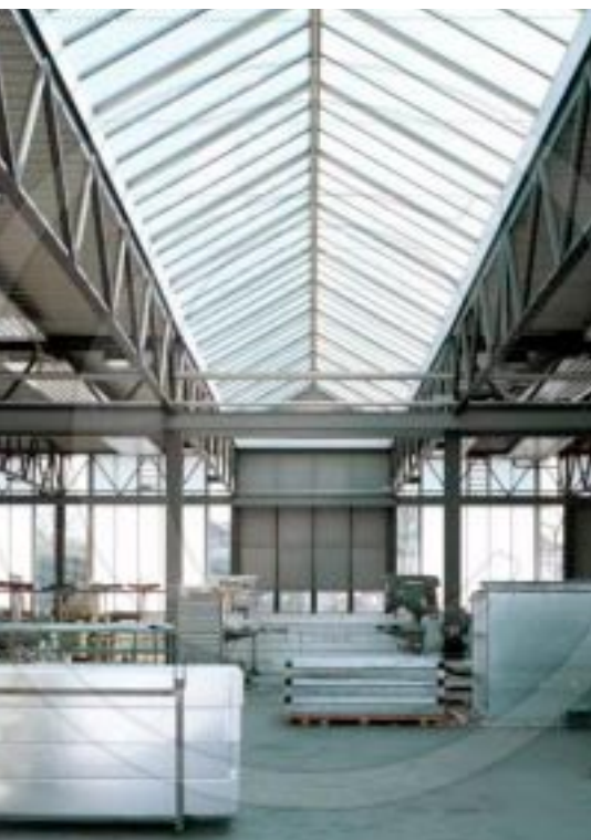
Das Heizen großer Hallen ist meist problematisch.
