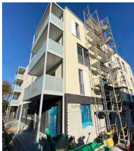
Ende dieses Jahres sollen die Wohnungen in der Stauerstraße bezugsfertig sein.
