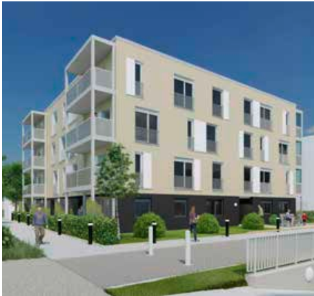
Das Neubauprojekt an der Hasenwaldstraße wurde in Modulbauweise realisiert.
