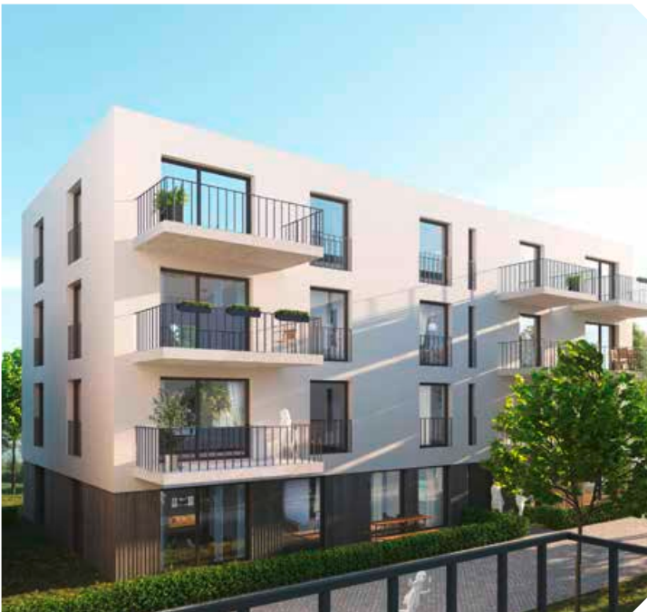
Die Wohnungen im „Wiesenacker“ werden mit Kalter Nahwärme versorgt.
